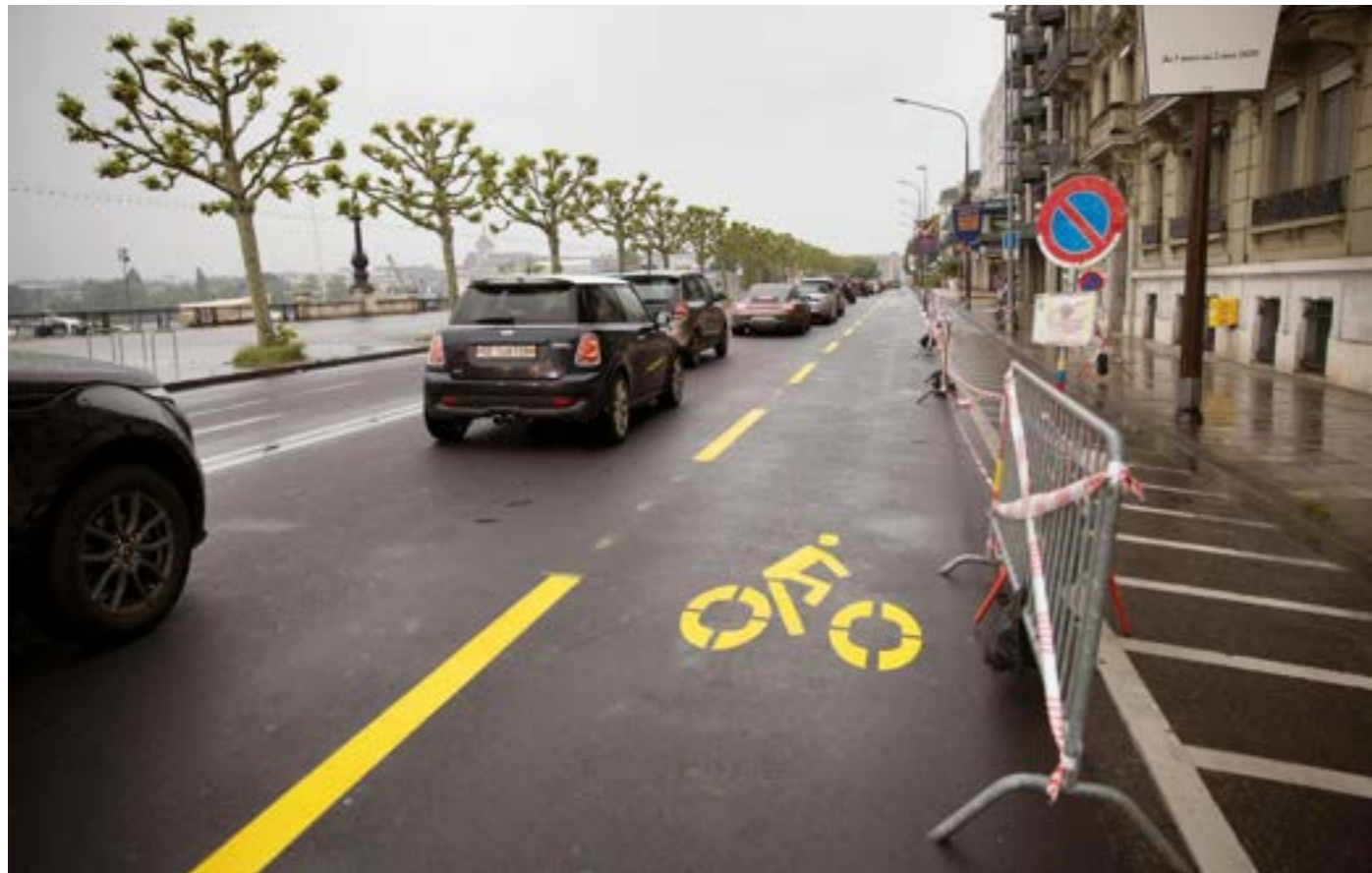
Nouvelles voies cyclables mises en place à Genève pendant le confinement
