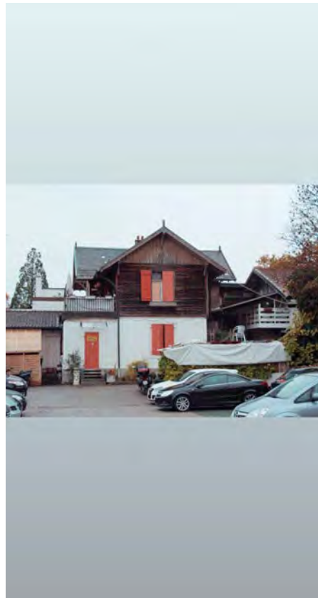
maison ancienne- rue Faubourg de Cruseilles
